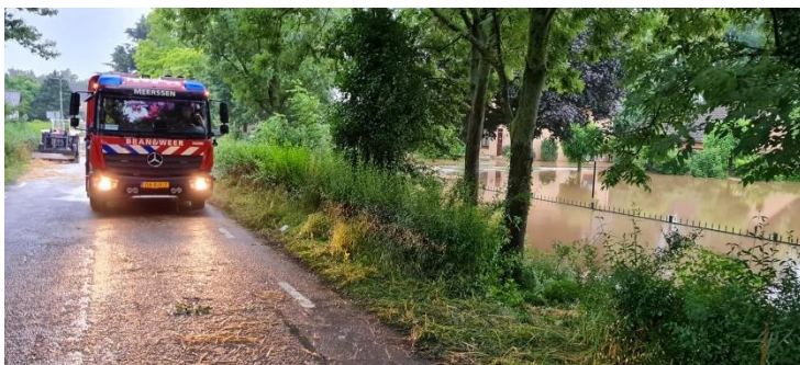
Afbeelding 3 Werkzaamheden in Meerssen
